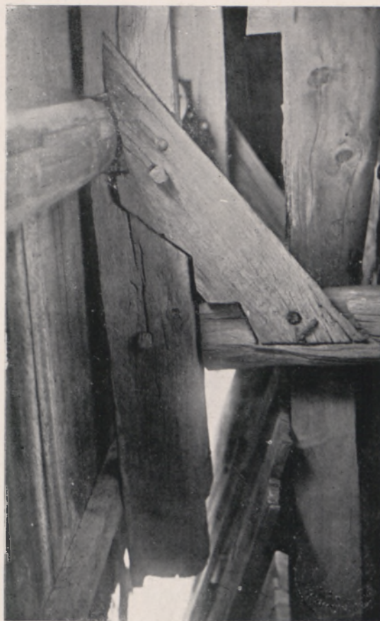
Fig. 8. Słupki zewnętrzne i dolne zastrzały.
