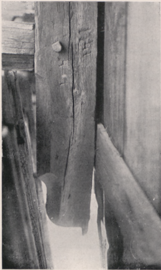
Fig. 13. Słupek fazowany z datą 1541.
