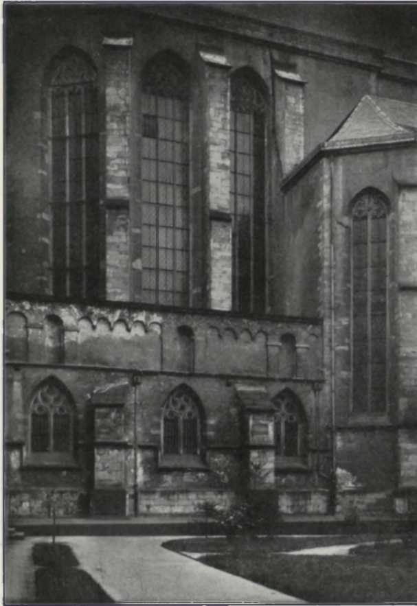
Fig. 94. St. Maria-Himmelfahrt. Nordseite des Chores.
