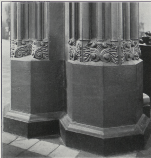
Fig. 97. St. Maria-Himmelfahrt. Pfeilersockel.
