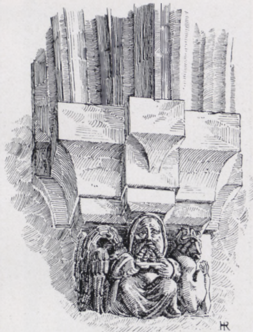
Fig. 21. St. Gereon. Gewölbekonsole in der Vorhalle.
