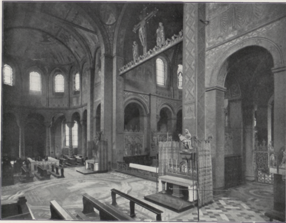
Fig. 149. St. Maria im Kapitol. Blick in den Ostbau.
