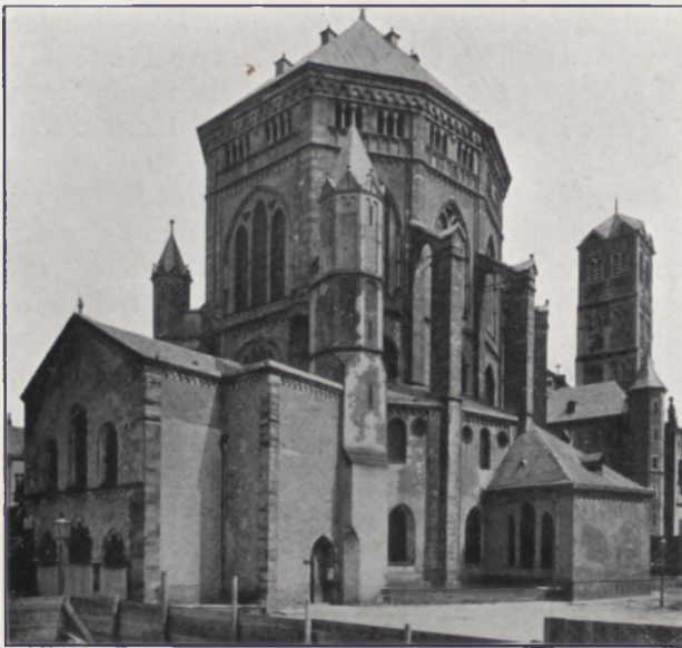
Fig. 8. St. Gereon. Ansicht von Südwesten vor der Wiederherstellung.
