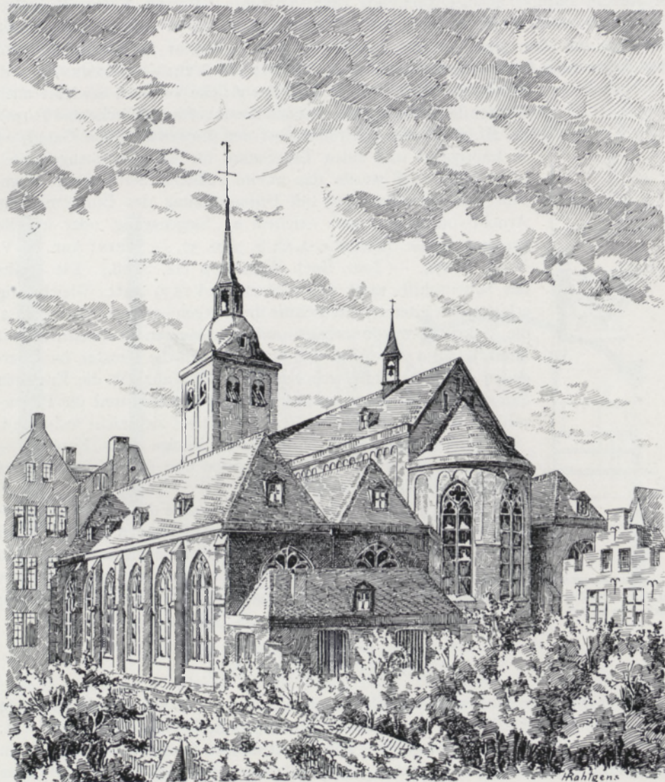
Fig. 76. St. Johann Baptist. Ansicht von Südost.
