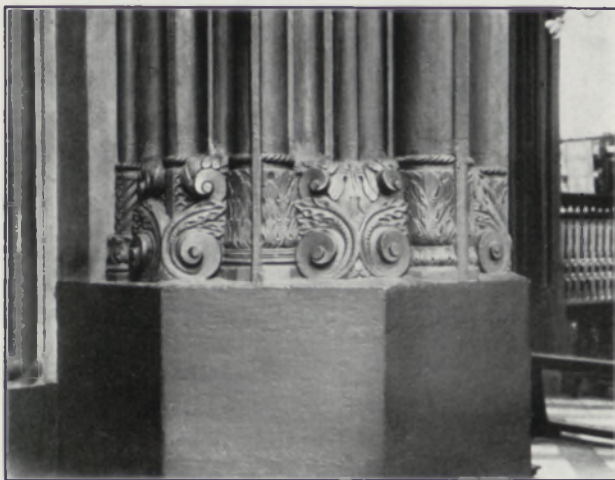
Fig. 98. St. Maria Himmelfahrt. Pfeilersockel.
