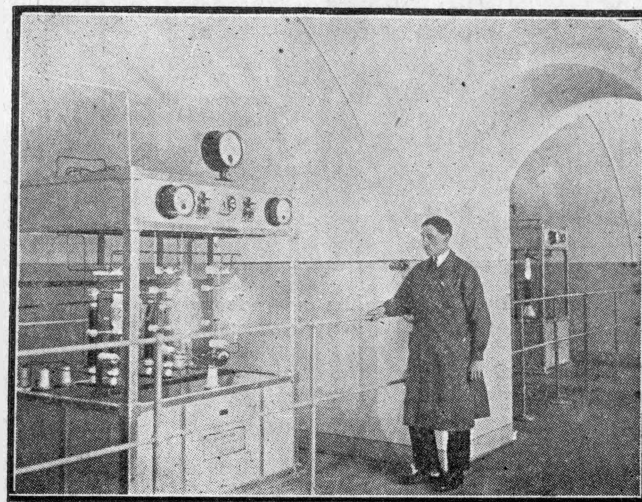
Oscylator lampowy, wytwarzający prąd zdolny do wypromieniowywania w przestrzeń energii elektrycznej.
