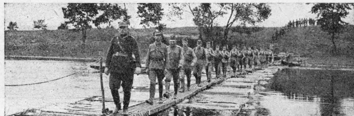
Przeprawa po kładce.
