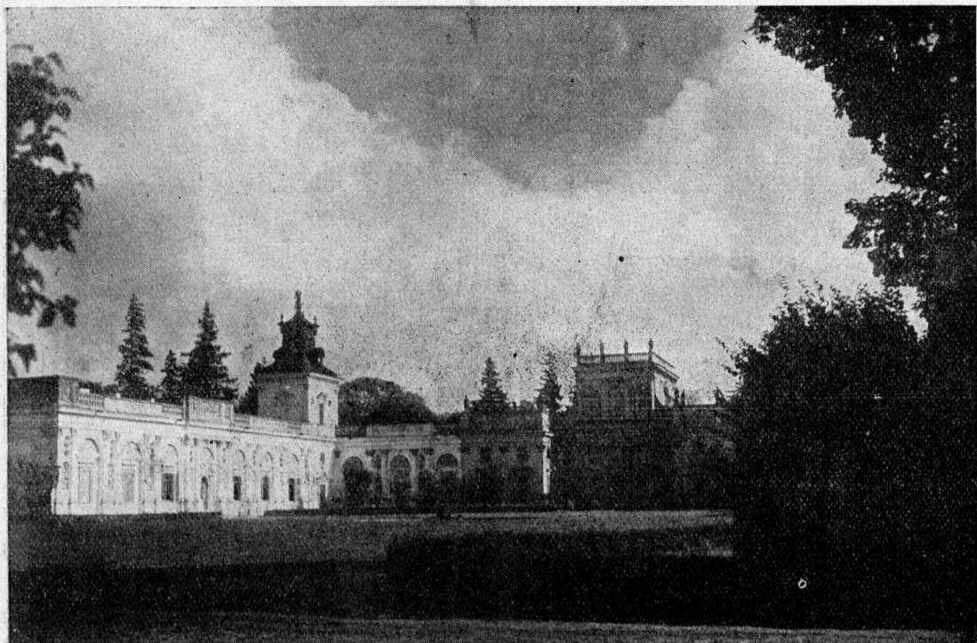
Widok ogólny pałacu od strony wjazdu.
