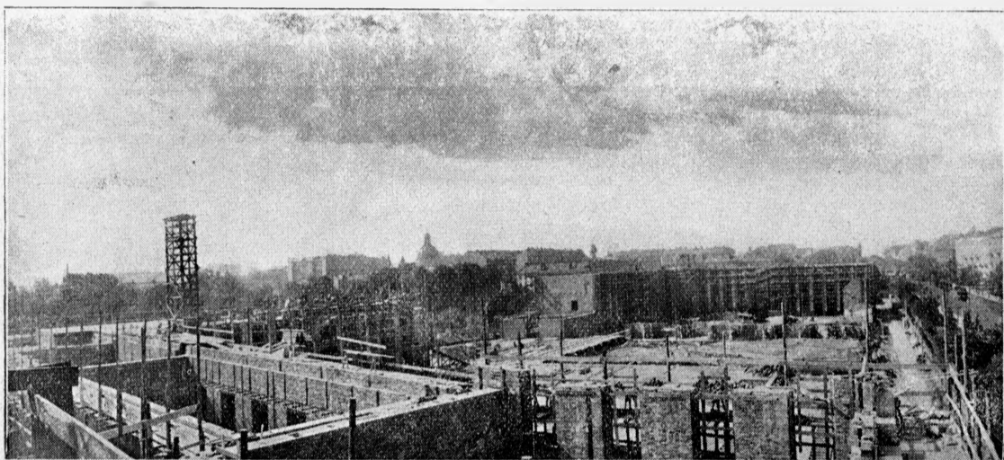
Budowa Muzeum Narodowego w Warszawie. Stan robót w końcu września.
