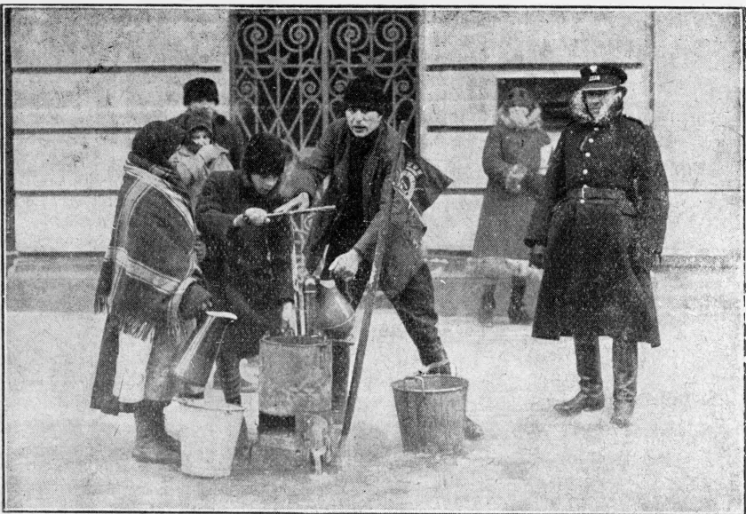
Wielkie mrozy uszkodziły w r. b. w bardzo wielu miejscach sieć wodociągową w Warszawie
