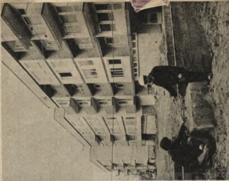
Osiadła dla górników kopalni Dębińskiego buduje się nową metodą, przy użyciu szalunków tunelowych (stalowych) francuskiej firmy „Outinord”. Domy mogą być bardziej urozmaicone, choć na zdjęciu tego nie widać. Za to budowa jest tańsza.
