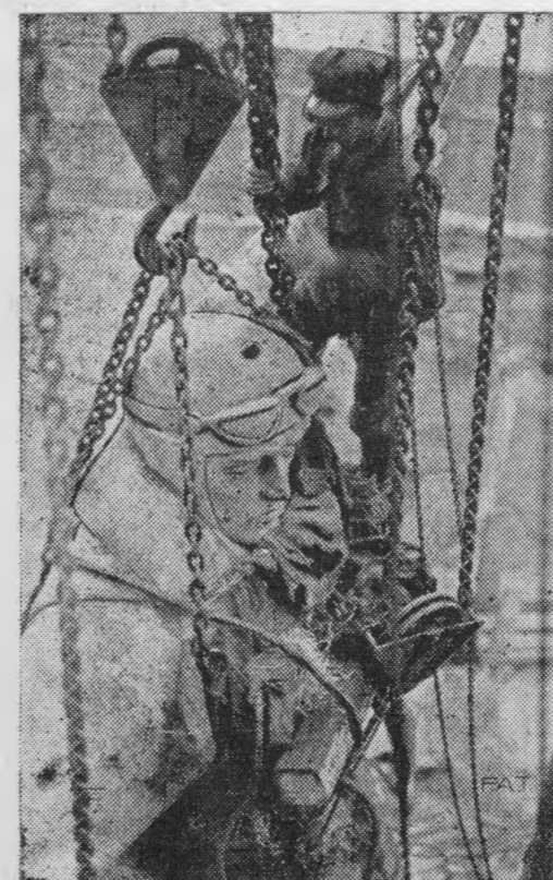
W dniu Święta Niepodległości odbędzie się odsłonięcie pomnika poległych lotników na Placu Unji Lubelskiej w Warszawie. Pomnik ten o wymiarach monumentalnych, jest dziełem znanego rzeźbiarza prof. Wittga. Ilustracja nasza przedstawia pracę przy montowaniu olbrzymiego posągu lotnika.
