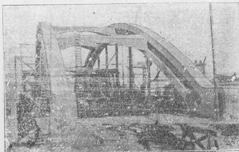
Na zdjęciu naszym widzimy wielki wiadukt żelbetowy wybudowany na moście węglowym w porcie w Gdyni, przeznaczony dla ruchu kołowego. Wiadukt oddany będzie do użytku z wiosną r. b.
