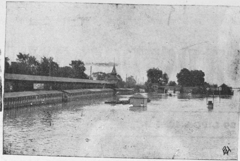
Widok na plażę koło mostu Poniatowskiego, zstąpione aż do poziomu kabin.
