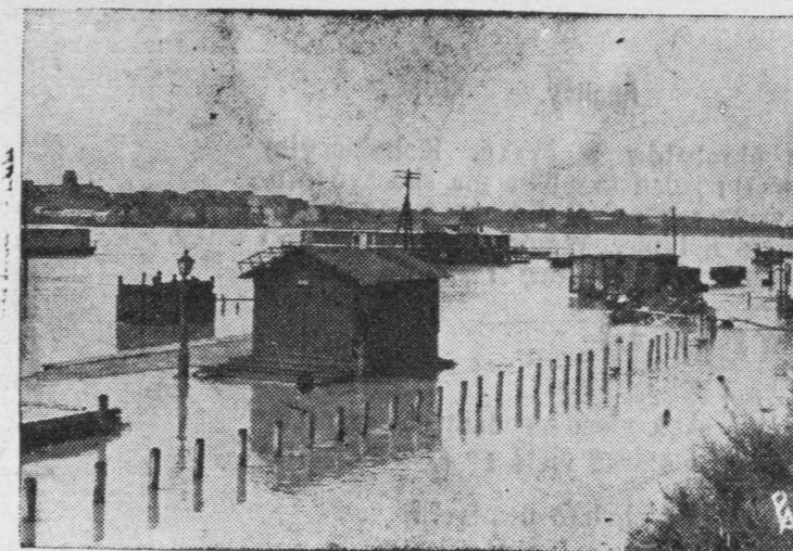
Stacja towarowa kolejki wąskotorowej koło mostu Kierbedzia — pod wodą.
