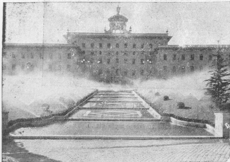
Nowe instalacje hydrauliczne w ogrodach Watykańskich pozwalają na automatyczne wytwarzanie sztucznego deszczu. Instalacje te służą jednocześnie do składowania olbrzymich ilości wody w miejscach zagrożonych pożarem. Na zdjęciu — stałe hydranty zlewające kwietniki w ogrodzie Watykańskim przed pałacem gubernatora.
