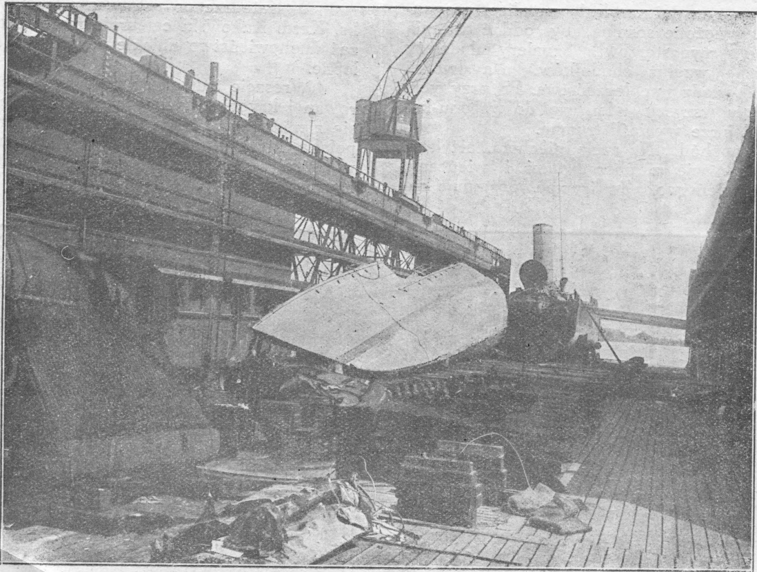
Naprawa „Kaszuba” w Stoczni Gdańskiej. Widać leżący kadłub torpedowca, rozciętego na dwoje w czasie wydobywania z wody. Praca idzie sprawnie i zapewne niedługo wróci „Kaszub” w szeregi naszej floty wojennej.
