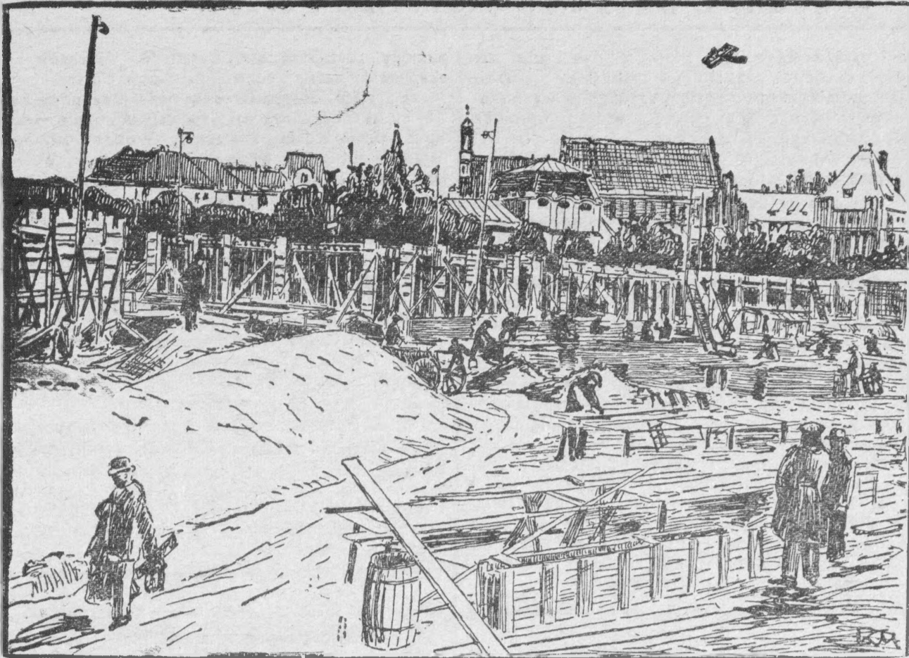
Obecny stan robót przy budowie gmachu wojewódzkiego w Toruniu.
