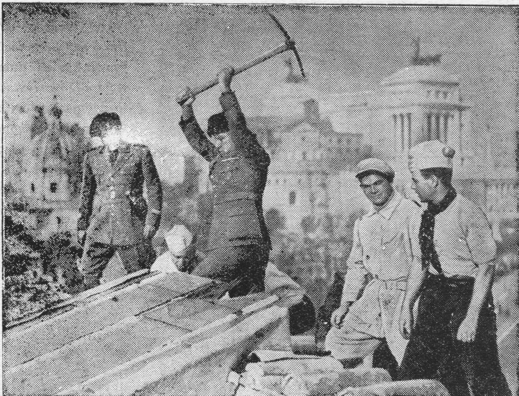
Przy nowej ulicy via dell'Impero w Rzymie powstanie wielki dom faszystowski. Trzeba rozebrać kilka starych budowli. Mussolini z kilofem w ręku rozpoczął pracę.
