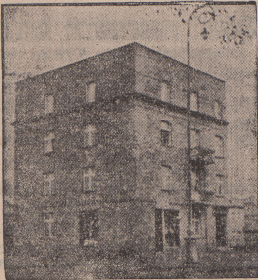
Nowa budowa naszego członka właśc. domu p. Piotra Kamińskiego, Tczew, Wybickiego 27, poz. zł 8.000,—
