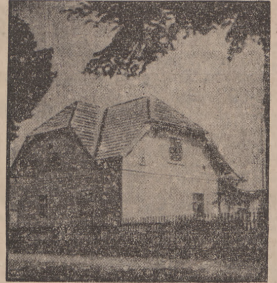
Nowa budowa naszego członka p. dyr. C. Kreczego Poznań, ul. Marsz. Focha 188a, pożyczka zł 14.000.—
