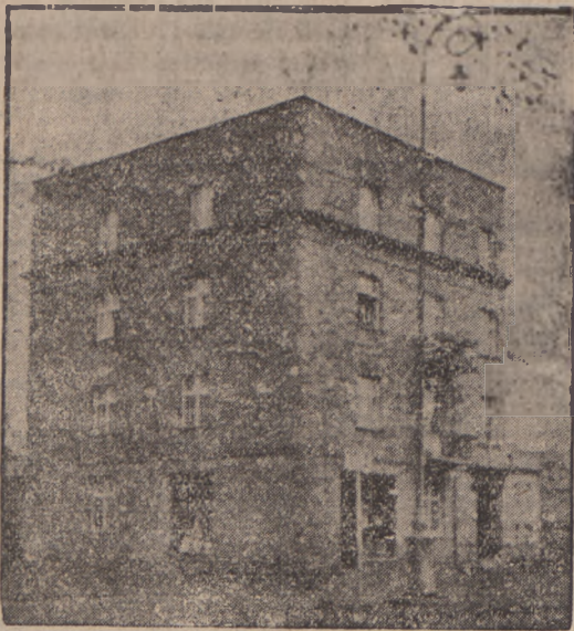
Nowa budowa naszego członka właśc. domu p. Piotra Kamińskiego, Tczew, Wybickiego 27, poż. zł 8.000.—
