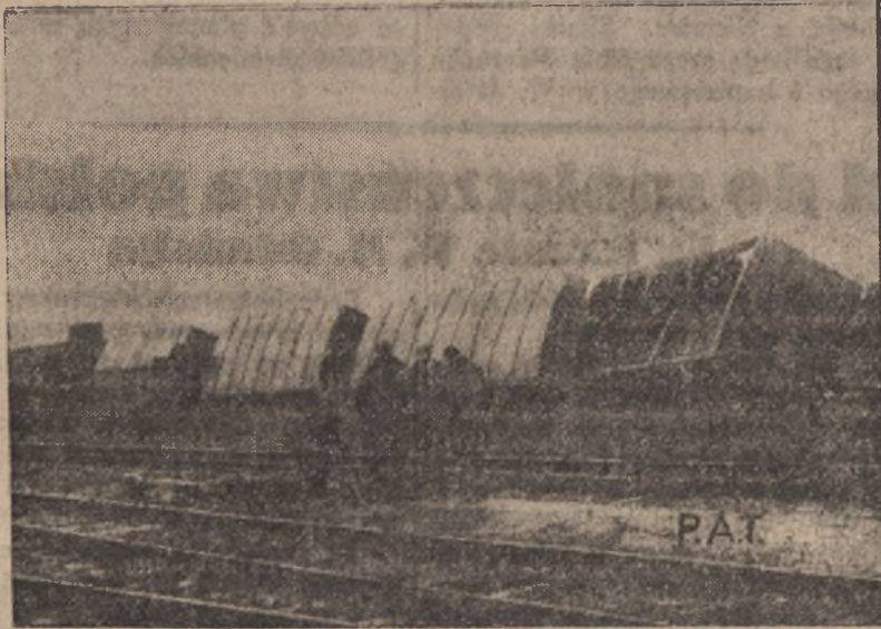
Nad Lublinem i okolicą przeszła trąba powietrzna, czyniąc ogromne szkody i powodując śmierć wielu osób. Rozszalały huragan zrywał dachy z domów, wyrwał pociągi i kominy fabryczne, wyrwał drzewa z korzeniami. — Zdjęcie przedstawia pociąg towarowy zrucony z toru przez huragan.
