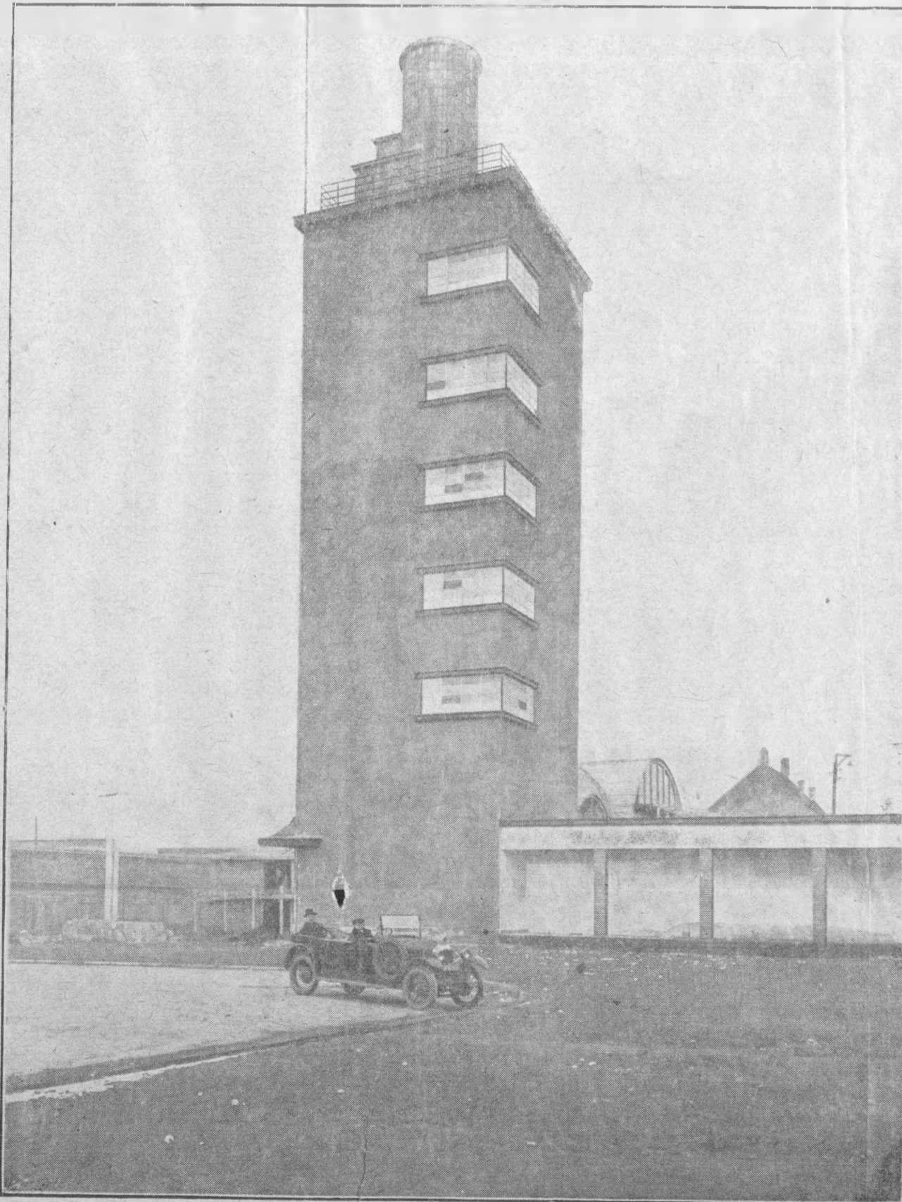
Wieża obserwacyjna na terenach Zachodnich P. W. K.
