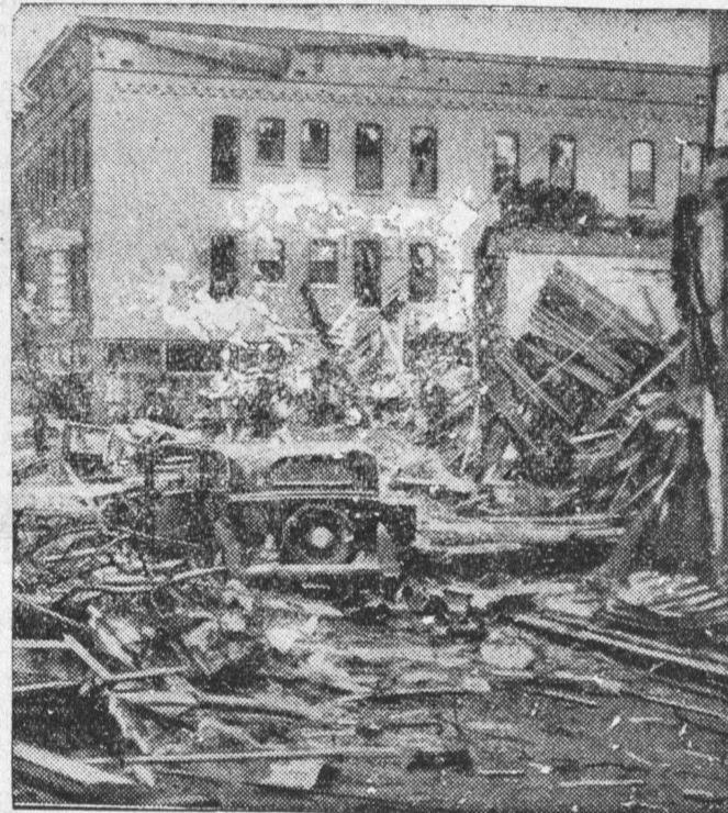
Powyższe zdjęcie dokonane zostało tuż po przejściu straszliwego orkanu w mieście Gainsville, w stanie Georgia. Wicher zniszczył wiele domów, grzebiąc pod gruzami przechodniów i przejeżdżające samochody.
