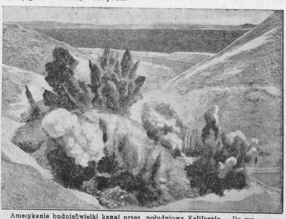
Amerykane budują wielki kanał przez południową Kalifornię. Do wydobywania ziemi w skalistych okolicach używa się dynamitu.
