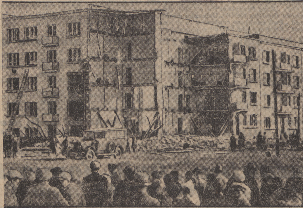
Jeszcze jedno zdjęcie zdemolowanego bloku domów Z. U. P. w Gdyni.
