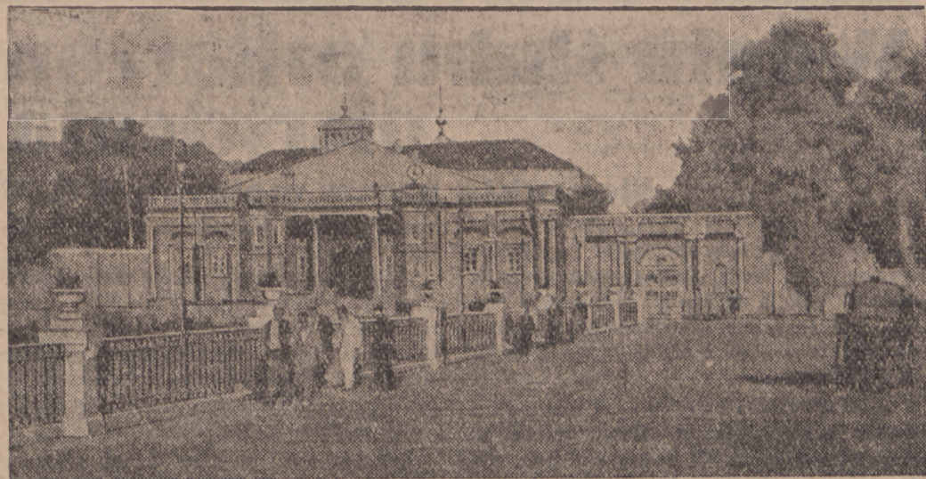
W gmachu parlamentu perskiego w Teheranie wybuchł pożar, który zniszczył doszczętnie cały gmach. Pożar powstał wskutek wadliwej budowy pieca.
