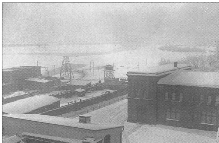
II. 3. Koszary Raclawickie, 1925 – część budynku dydaktycz- nego
