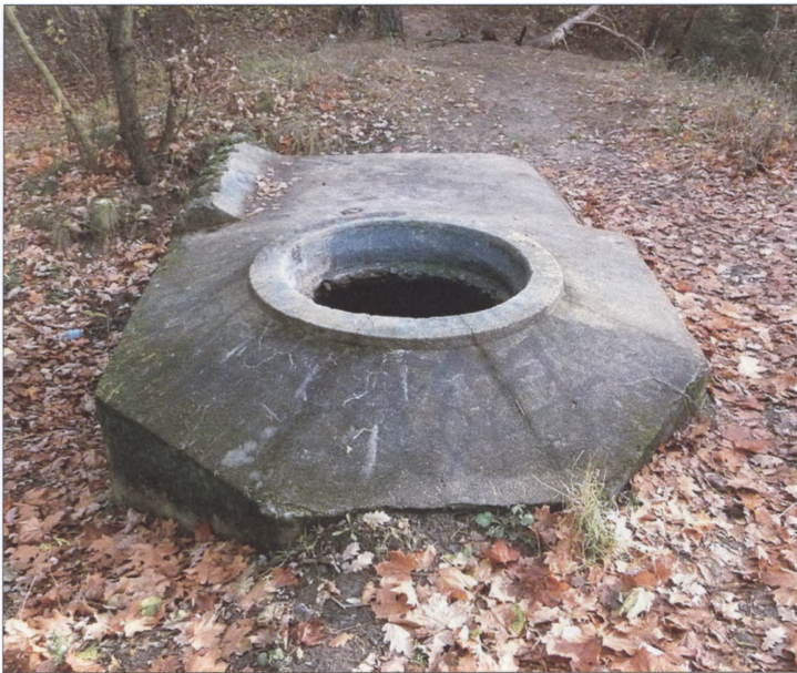
Il. 3. Schron Ringstand 58c „Tobruk” nr 2 wbudowany w wał główny fortu piechoty Strzemięcín w Grudziądzu – fot. autor
