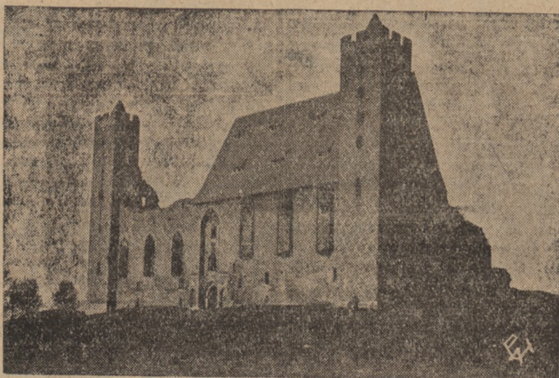
Widok ogólny (od strony południowej) zamku krzyżackiego w Radzynie w pow. grzdzickim. Zamek ten był niegdyś siedzibą polskich starostów grodzkich. Zbudowany w XIII wieku w stylu całkowicie gotyckim, przebudowany został w XVI wieku.
