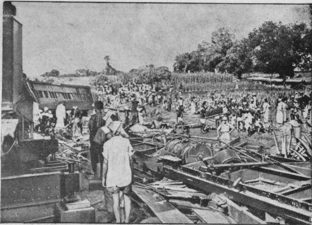
Największa w historii kolejarstwa południowych Indii katastrofa kolejowa wydarzyła się w pobliżu Madras na skutek podmytego przez ulewę toru. 4 wagony zostały rozbite, a przeszło 100 pasażerów zginęło pod gruzami. Na zdjęciu uprzątnięcie rozbitego pociągu.
