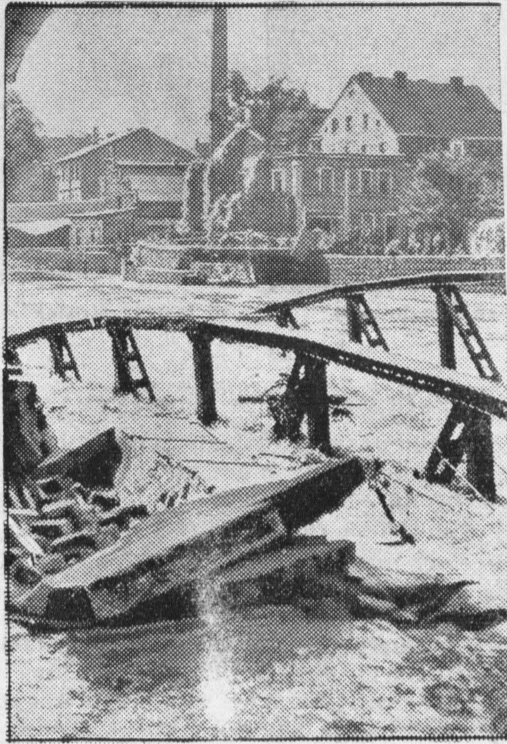
Zniszczony przez powódź most na Ślasku niemieckim.
