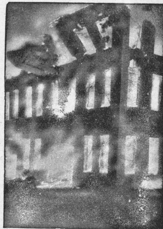
Pożar zniszczył w Barton Ville w Illinois (USA) olbrzymią fabrykę. Fotograf uchwycił moment, gdy mury się zawalają. Szkody obliczono na 500 tys. dolarów.
