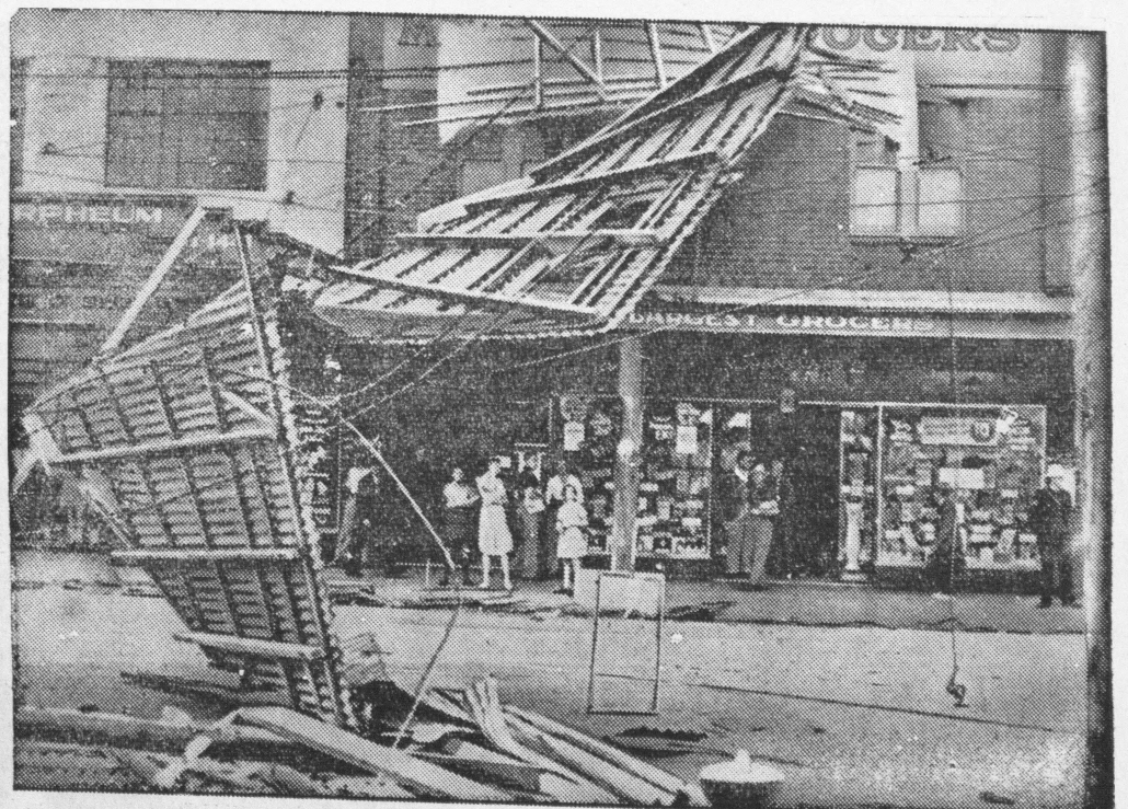
Nad Sydney, stolicą Australii, szalał orkan, który wyrządził w mieście i porcie szkody, wartość przeszło 600 tys. ft. szt. Na zdjęciu część dachu zerwana z domu towarowego.
