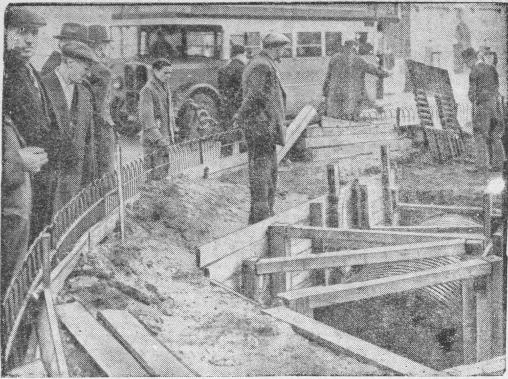
W Londynie dobiegają końca prace przy budowie tunelu przeciwlądziwo-gazowego. Na zdjęciu duże stalowe rury, które zostaną zasypane ziemią.
