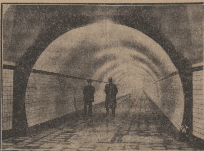
Gigantyczne twory techniki współczesnej — tunele pod rzeką Skaldą w Belgji. Jeden z nich długości 500 m. przeznaczony jest dla pieszych, drugi, długości 2 km., dla ruchu kołowego. Otwarcie tunelu nastąpi 10 września b. r.
