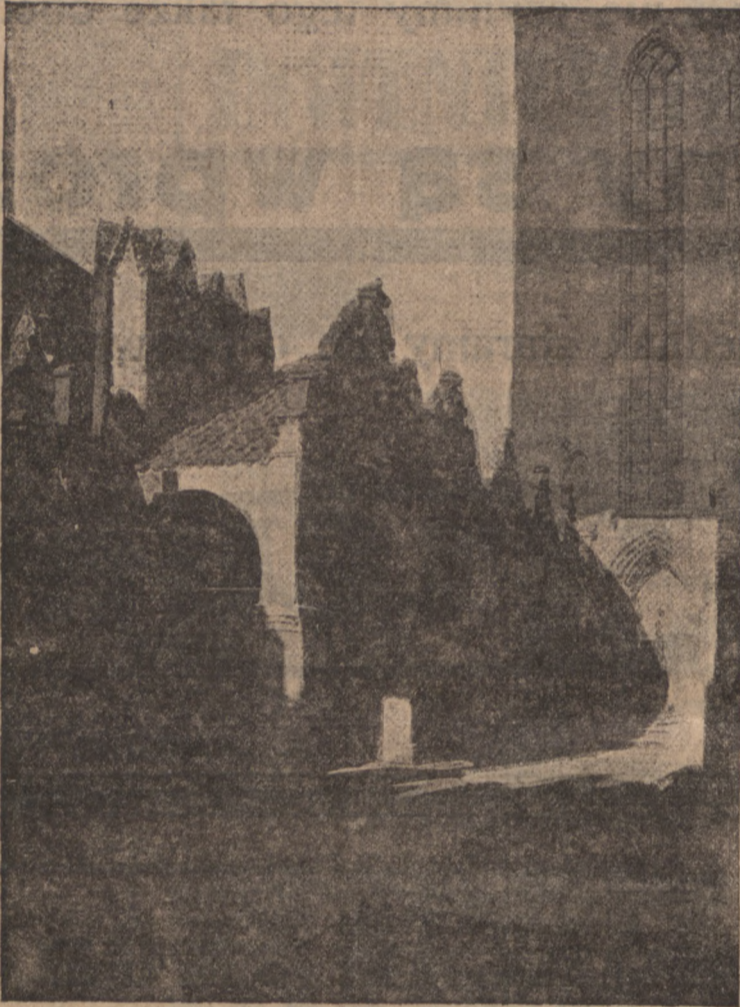
Piękny krążanek kościoła Marjańskiego dotykający do zagrożonej ściany.
