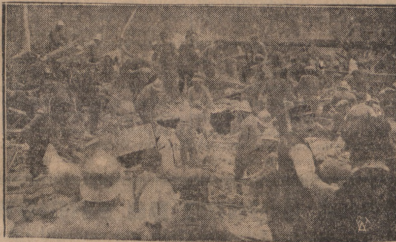
Jak to już donosiliśmy na przedmieściu Paryża Billancourt wybuchł wielki kocioł w fabryce samochodów Renaulta. Eksplozja była tak silna że dach kołtowni wyleciał w powietrze. Odłamki żelaza i cegiel posypały się na sąsiednie pawilony fabryczne. Pod naporem rumowisk dach jednego z pawilonów załamał się, grzebiąc pod gruzami robotników. Na ilustracji widzimy akcję ratowniczą, przy wydobywaniu zasypanych robotników.
