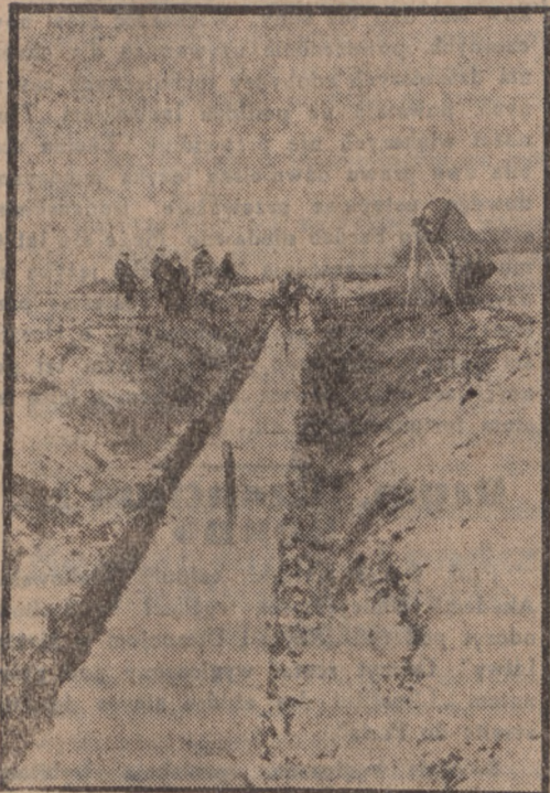
Na łąkach augustowskich widać prace melioracyjną.
