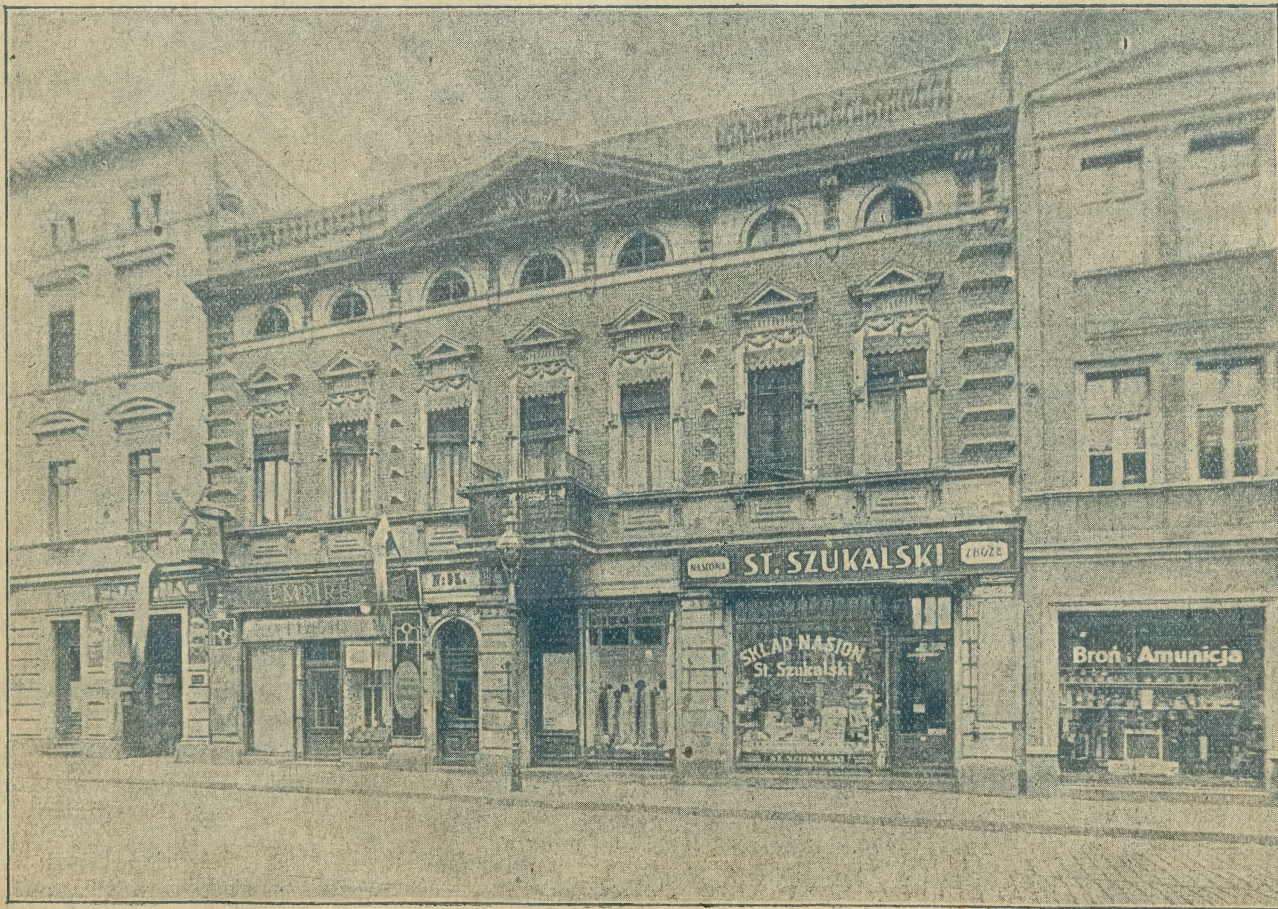
Fronton domu własnego firmy St. Szukalski w Bydgoszczy, przy ul. Dworcowej 95a
