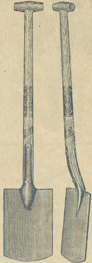
1582D. Lopata ogrodowa , stalowa „Dresdensia“ (sztychówka) z grabowym trzonkiem zakończonym rękojeścią w kształcie litery D. Blat i okucie do trzonka są odkute z jednej sztuki stali, blat jest owalno-prostokątny, długości i szerokość blatu 28½×18½ cm. Nadaje się do obcinania kątów, trawn., klomb. itp. prac w ogrodzie.
