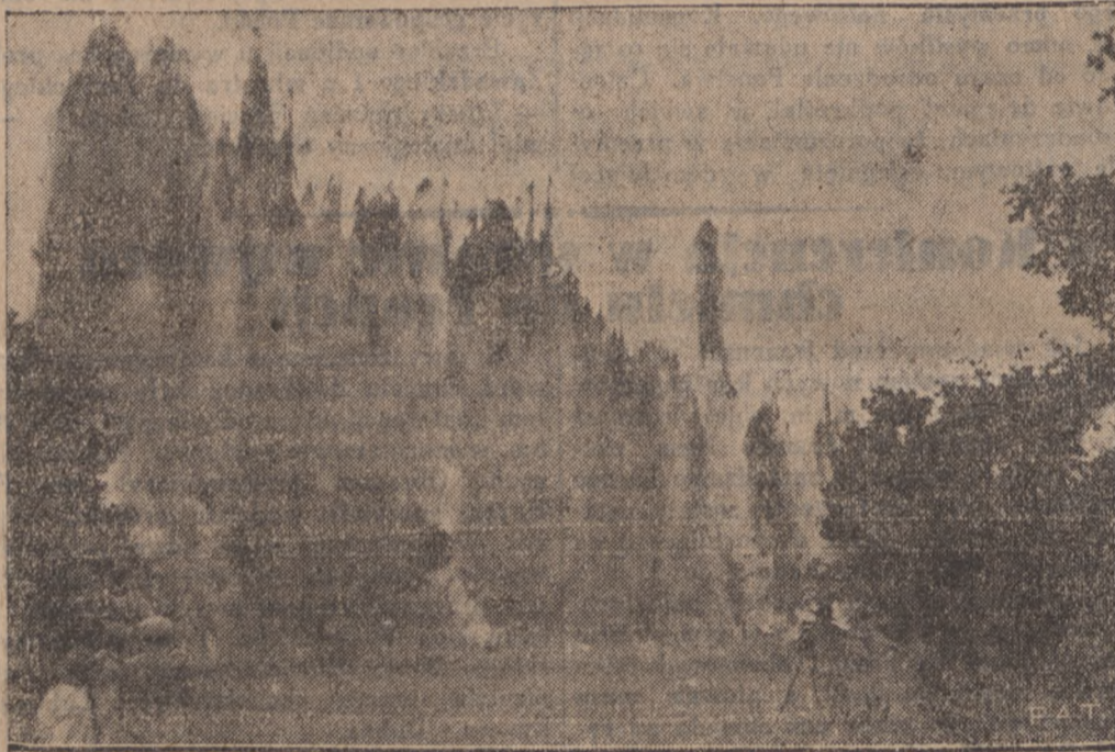
Przed kilku dniami użyto po raz pierwszy w Polsce dynamitu do prac melioracyjnych. — mianowicie w celu wyrównania bardzo krętego biegu rzeki Orzuc od Drożdżowem na Pole-siu, połączono dwa węzły rzeki linją nabożów dynamitowych, których wybuch utworzył no-we, głębokie i równe koryto rzeki. — Ilustracja nasza przedstawia groźny widok wybuchu półtonowego ładunku dynamitu. Praca ta wykonana została przez Państwową Wytwórnję Prochu pod kierunkiem inż. Raczyńskiego.
