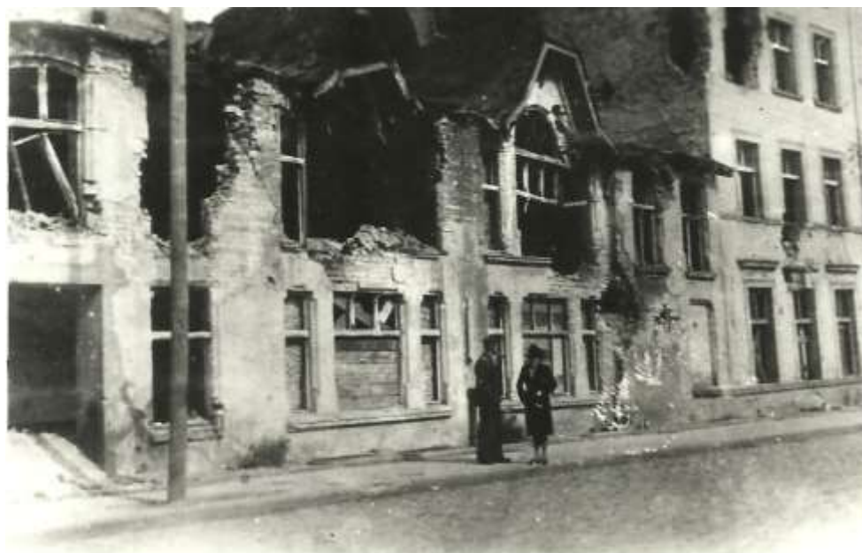
Zniszczenia wojenne budynku kina „Apollo” (Ze zbiorów Z. Zawadzkiego)
