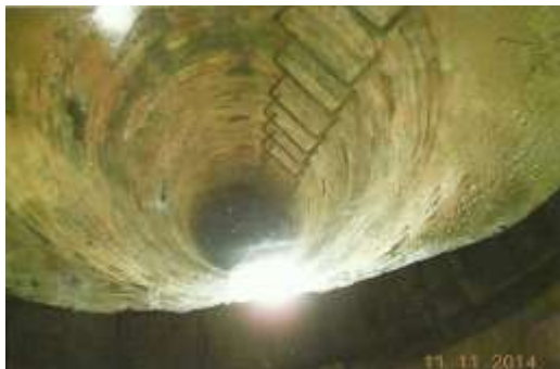
Studnia w piwnicy kamienicy przy ul. Szewskiej 5, o głębokości kilkunastu metrów.
