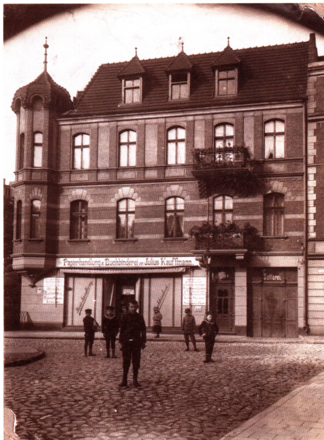
Budynek narożny nad Trynką przy ul. Małogrobłowej – u wylotu ul. Skłodowskiej-Curie, ok. 1913 r. Zniszczony w 1945 r.
