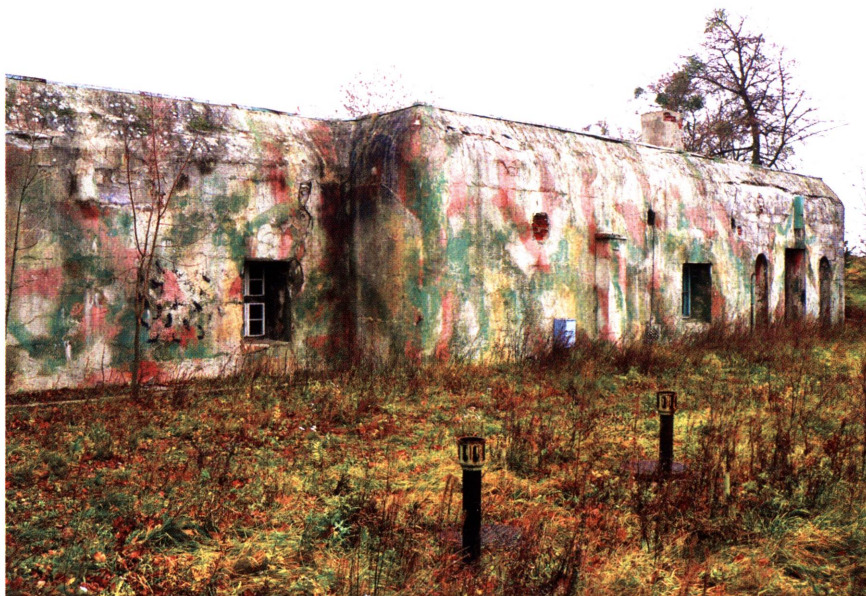
Schron radiostacji fortecznej – stan obecny
