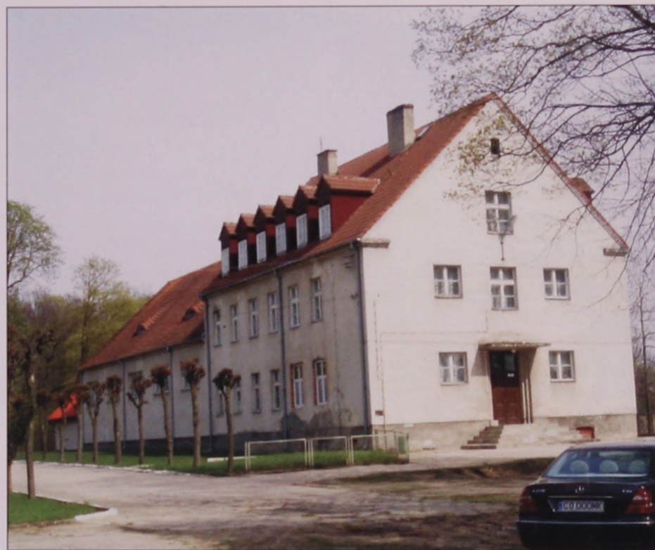
Internat z salą gimnastyczną (Zdj. autora z 2006 r.)
