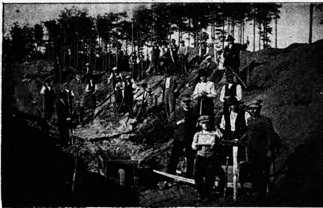
Powstańcy i Wojacy placówki Borowy—Młyn przy budowie własnej strzelnicy.
