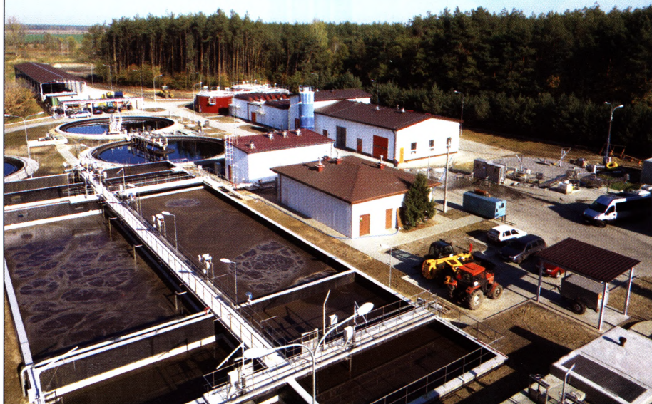
Modernizacja i rozbudowa oczyszczalni ścieków w Rudzie Bugaj
