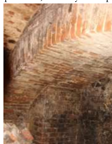
Most Bramy Bocznej. Widoczny szew między murami arkadowymi. Stan z 19.09.2014 r.
