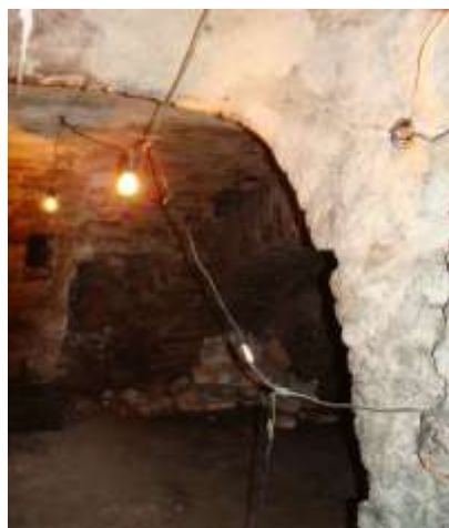
Most Bramy Bocznej. Widok ogólny. Stan z 19.09.2014 r.
