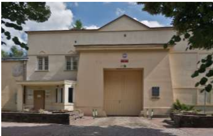
Brama wjazdowa Zakładu Karnego nr 1 w Grudziądzu.
