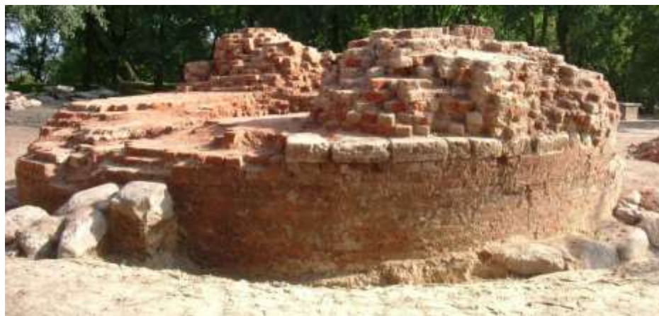
Ryc. 13. Relikty wieży Klimek. Z widocznymi blokami pierwotnego cokołu fundamentu. Widok od strony zachodniej. Stan 27.08.2006 r. fot. M. Szajerka.
