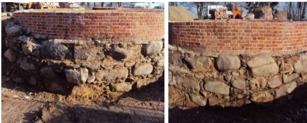
Ryc. 10-12. Fundament wieży Klimek. Stan z 14.02.2014 r., przed wykonaniem betonowego pierścienia, wzmacniającego fundament w związku z odbudową wieży Klimek. Fot. M. Sza-jerka.
