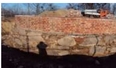
Ryc. 10-12. Fundament wieży Klimek. Stan z 14.02.2014 r., przed wykonaniem betonowego pierścienia, wzmacniającego fundament w związku z odbudową wieży Klimek. Fot. M. Sza-jerka.
