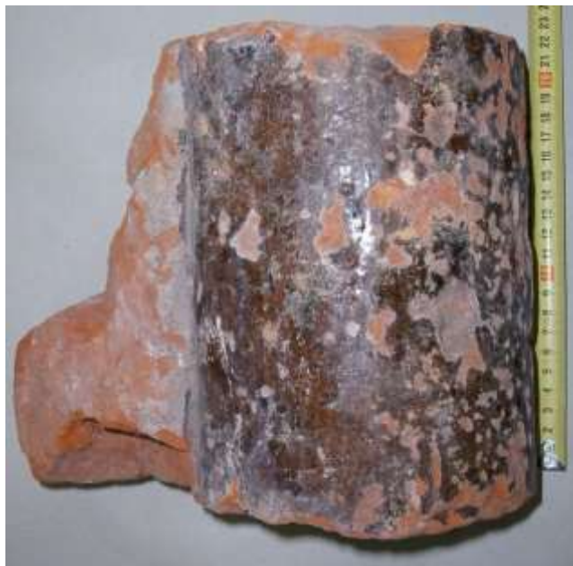
Ryc. 17. Fragment słupa kręconych schodów z wieży Klimek. Rzut pionowy. Stan z 7.12.2007 r. Fot. M. Szajerka.
