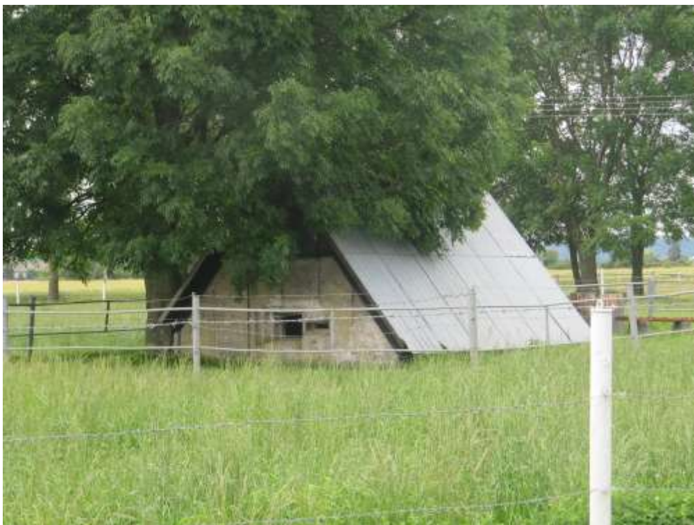
Marzec 1939 budowa schronów niemieckich.
