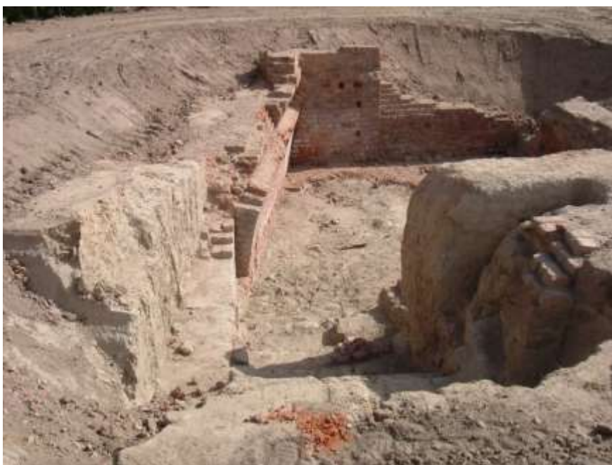
Ryc. 4. Piwnica nad mieszkaniem piekarza, ze sklepieniem zawalonym w 1603 r., (pomieszczenie I kondygnacji), bez śladów murów o grubości 3-4 m. Stan 25.09. 2009 r. Fot. M. Szajerka.
