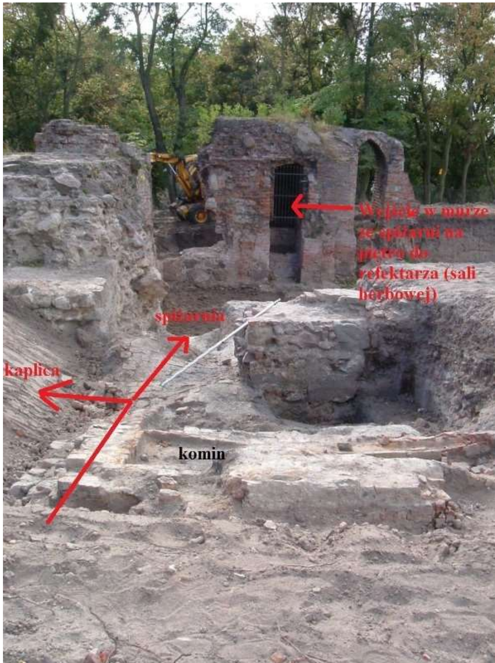
Ryc. 8. Ganek po stronie wschodniej, wyłożony cegłą przy skrzydle południowym. Na pierwszym planie widoczny fundament komina. Strzałkami zaznaczone wejścia do kaplicy na lewo oraz do spizarni na wprost. Stan z 25.09.2009 r. Fot. M. Szajerka.
