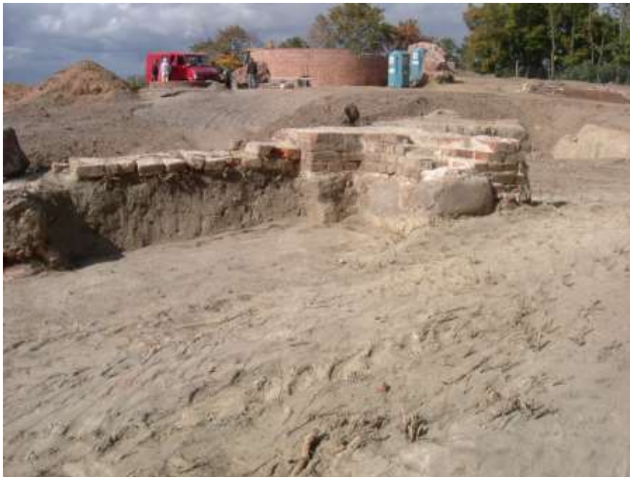
Ryc. 7. Relikty budowli po stronie wschodniej zamku wysokiego, nienaniesione początkowo na plan wykopów archeologicznych. Widok od stron wschodniej, w kierunku na wieżę Klimek. Widoczne są pozostałości drzwi na dziedzińcu zamku. Stan z 25.09.2009 r. Fot. M. Szajerka.
