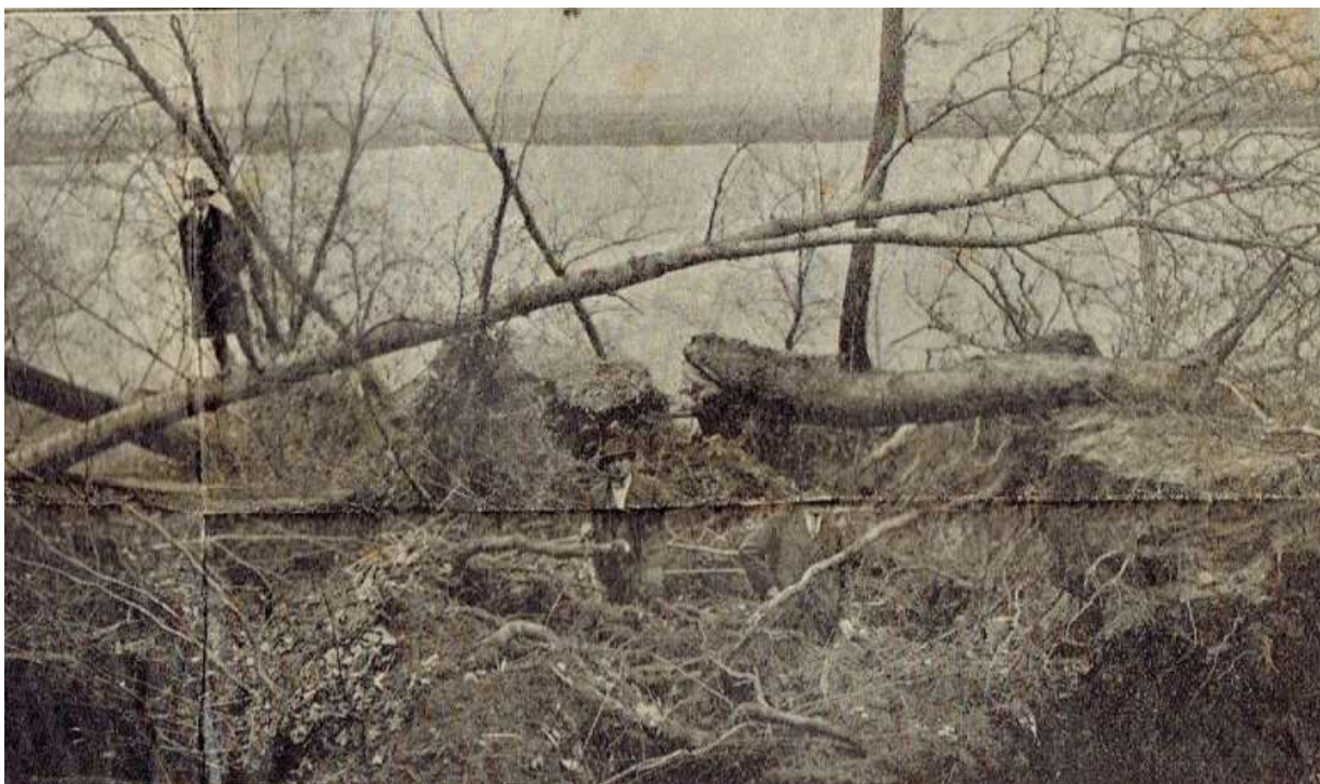
Z jaką gwałtownością nastąpiło obsunięcie się stoków góry na Strzemięcinie, wskazuje poniższa fotografia. Olbrzymie drzewa połamane na drzazgi i powywracane wraz z korzeniami zsunęły się do Wisły. Głębokość wyryw wynosiła niejednokrotnie 2 – 3 metry. Grupy wskazane na zdjęciu, leżą nad Wisłą na dawniejszej polanie pod wzgórzami.
