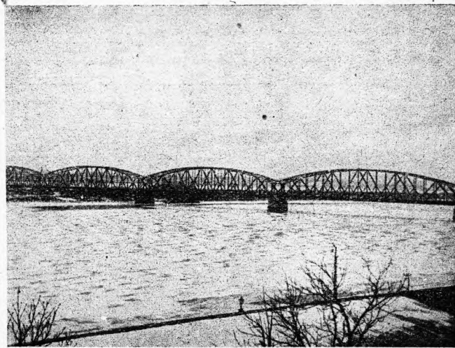
Przyszła zima i zakuta Wisłę w lodowe okowy. W dali widać nowy most toruński, po którym kursują już tramwaje
