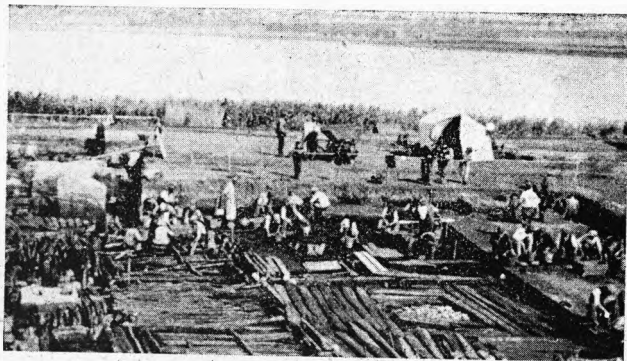
Żmudna praca przy odkopywaniu cennego znaleziska.
