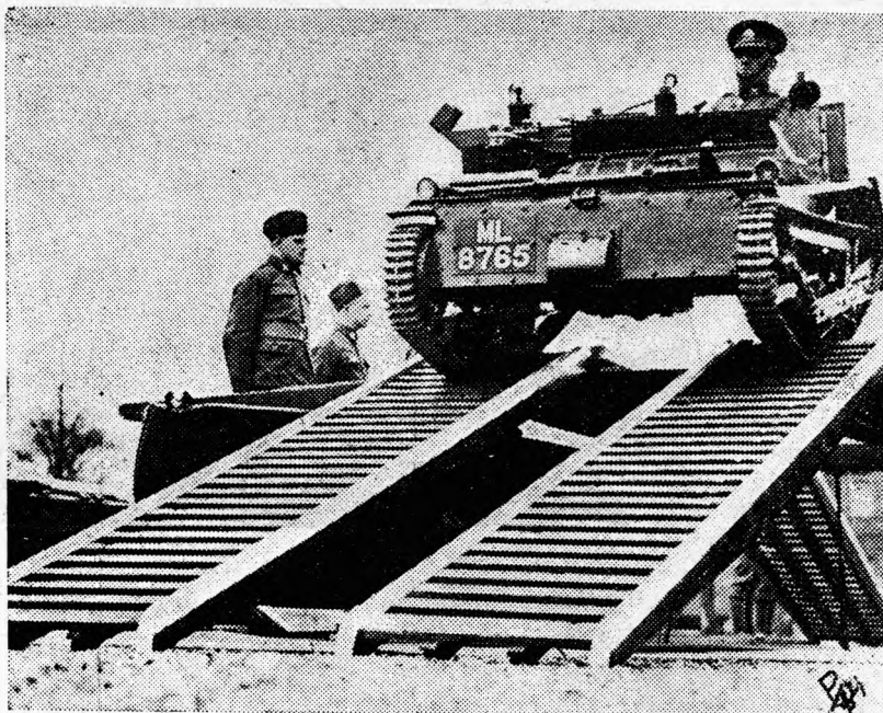
Próba mostu nowej konstrukcji w Anglii, przez który przejeżdża czołg
