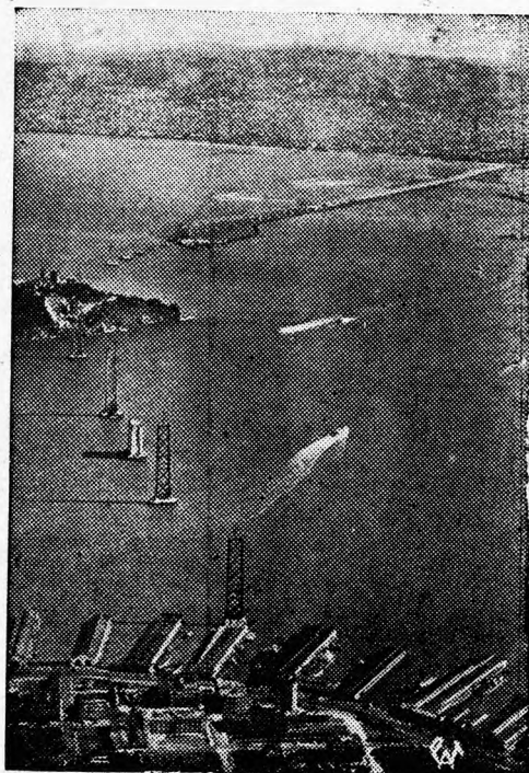
Zdjęcie nasze przedstawia budowę największego mostu na świecie, łączącego San Francisco z Oakland.
